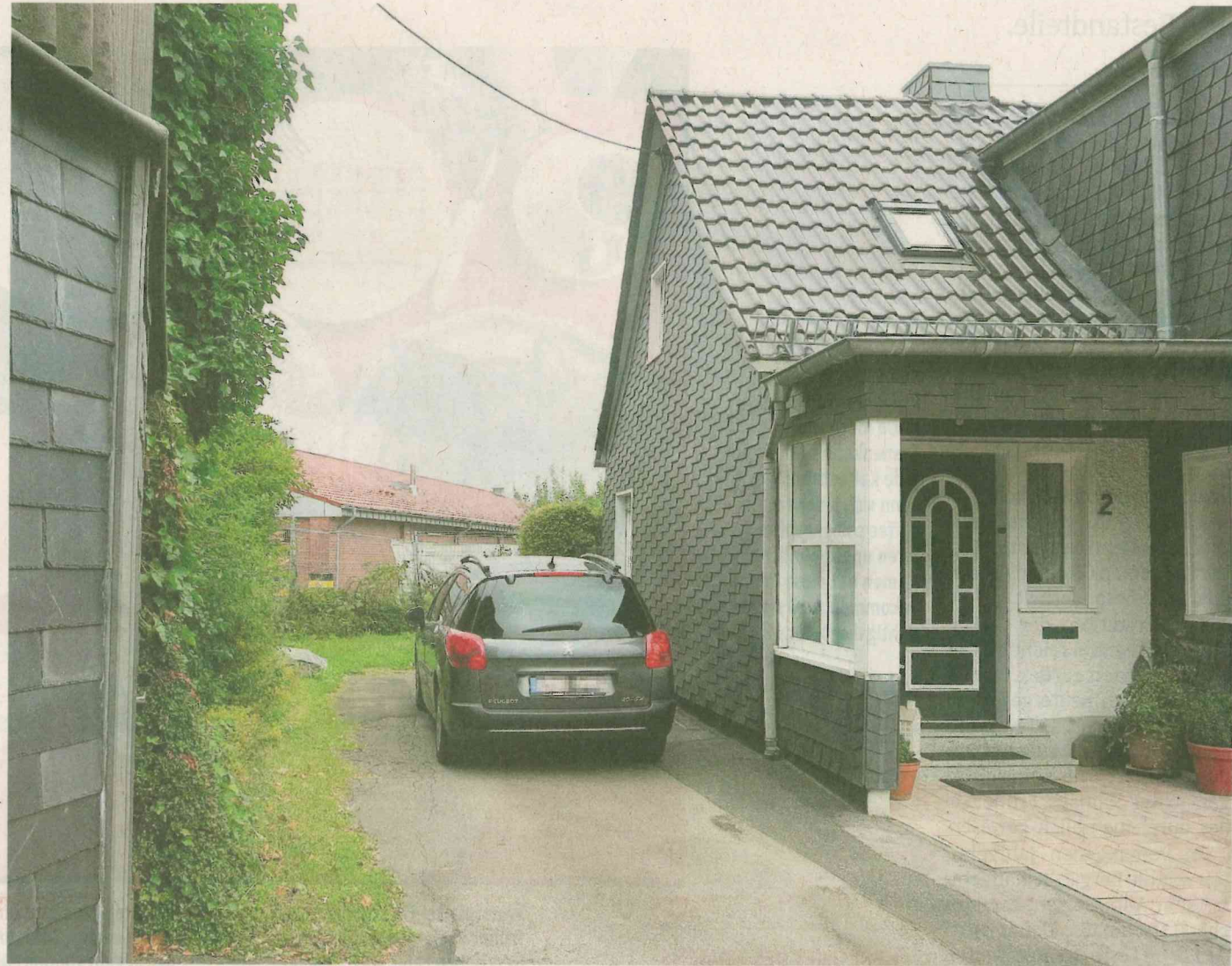
Früher fuhr die Straßenbahn zwischen diesen Häusern hindurch, künftig soll die Balkantrasse hier entlangführen. Am Haus Zenshäuschen Nummer 2 würde der Rad-Gehweg unmittelbar am Küchenfenster vorbeiführen.
