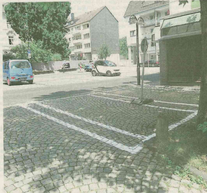
Um 15 Uhr war die Markierung noch falsch, später wurden die Linien der beiden unteren Parkplätze korrigiert. Foto: Leonard Fleck
