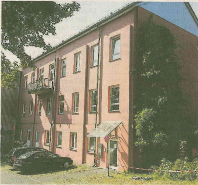
Der Ausbau des ehemaligen Ausländerzentrums an der Thomas-Mann-Straße ist fast fertig.
